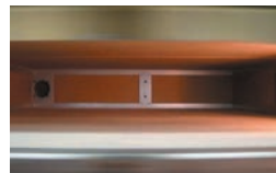
Cała komora wyłożona cegłą szamotową
